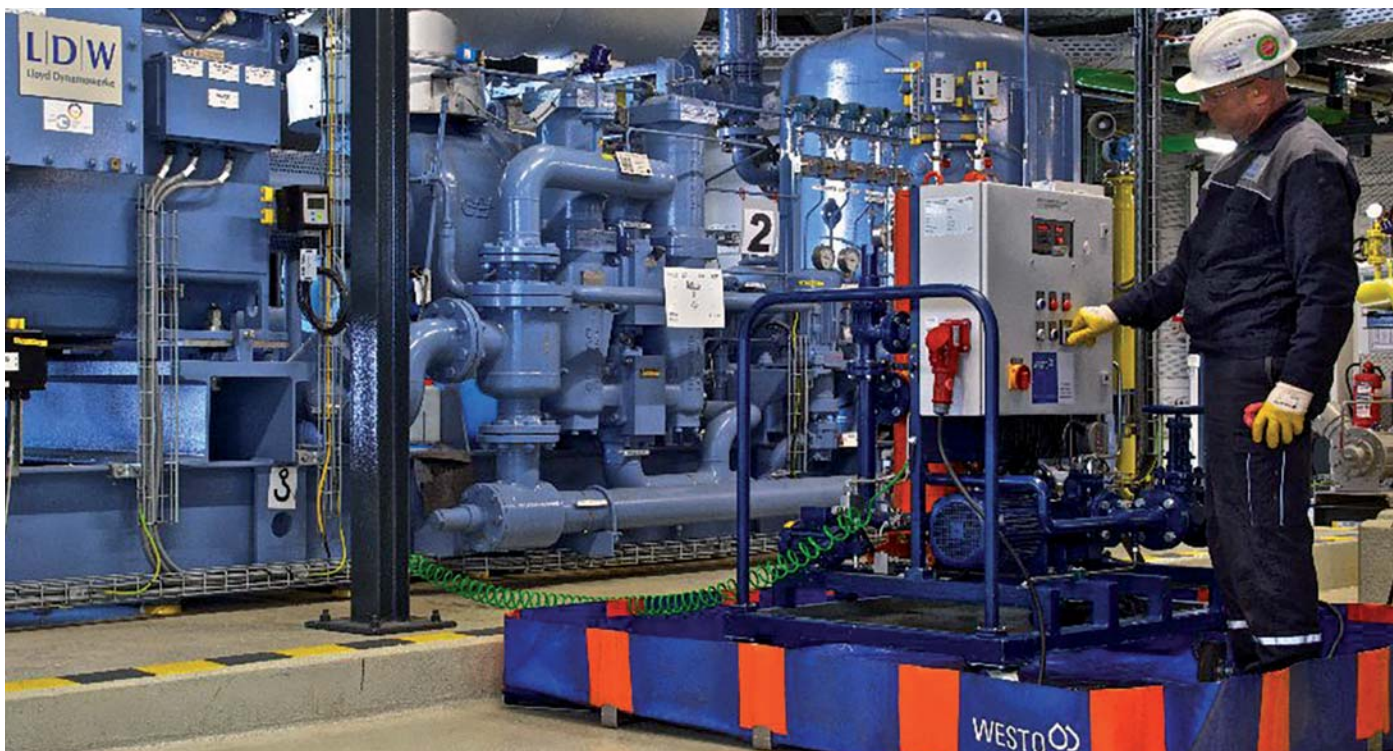
由WESTO和CURRENTA合作开发: 特别针对冷冻机中的螺杆压缩机设计的旁路过滤系统, 考虑了油路循环中氨 (NH 3 ) 所占比例。
